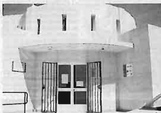
CENTRO INFANTIL (GDR ALCORNOCALES) > La rehabilitación de instalaciones de madera de Santa Catalina dio lugar a un centro infantil en las Matas de Teja al servicio de los niños de esta localidad. Con un coste de 240.000 euros ha sido subvencionado de 120.000.
